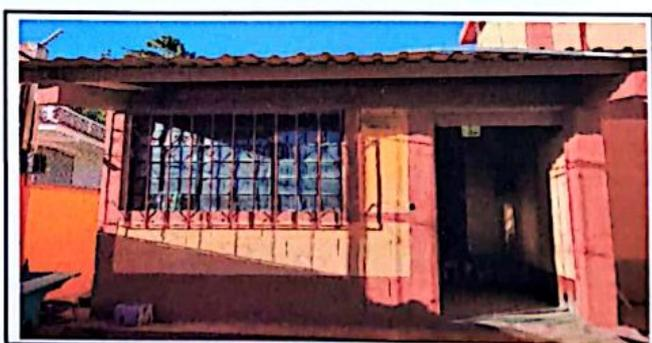
Foto 6: En frente se necesita unas vigas para soportar del techo.
