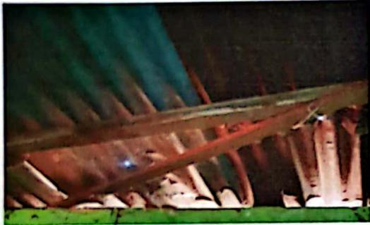
FOTO 1 laminas en mal estado con el tiempo se ha estado deteriorando
