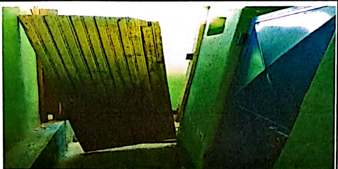
Foto 5: puertas de los sanitarios en mal estado por el tipo de material y ya sobrepasar su tiempo de vida.
