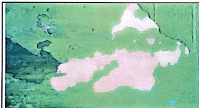
Foto 9: La pintura de las paredes del exterior se encuentra deteriorada.
