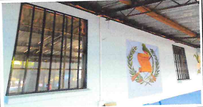
Foto 14: Finalización de la instalación de balcones.
