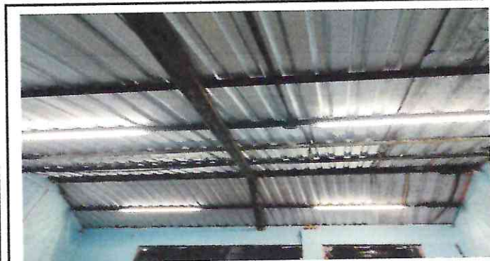
Foto 9: Instalación de lámparas en las aulas del modulo 3.
