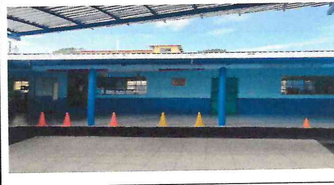
Foto 10: Canal de metal para bajada de agua pluvial instalado.
