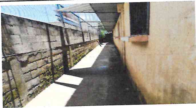
Foto 13: Finalización de losa de patio.
