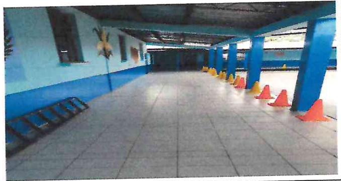
Foto 2: Finalización de colocación piso cerámico en el corredor.
