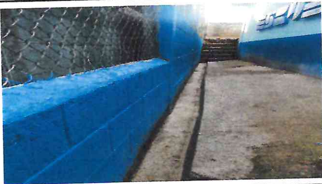
Foto 15: Finalización de cuneta de concreto.
