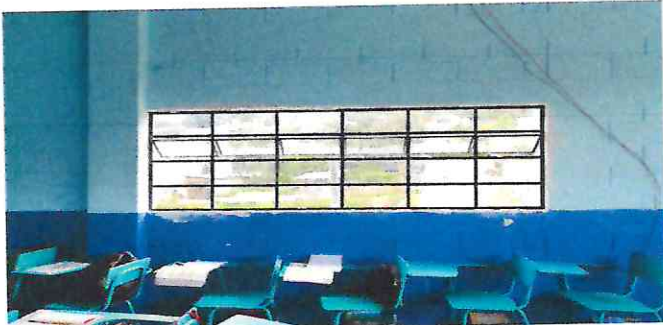
Foto 5: Ventanal ya instalado.
