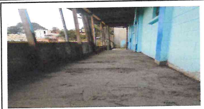
Foto 7: Losa de patio culminada.
