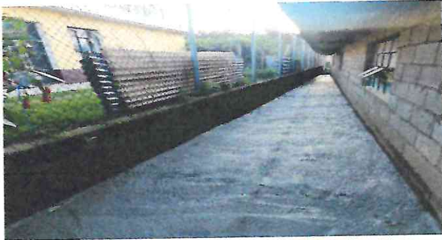
Foto 1: fundición de losa de concreto con un desnivel de 25 grados para que el agua continúe y no se quede estancada.
