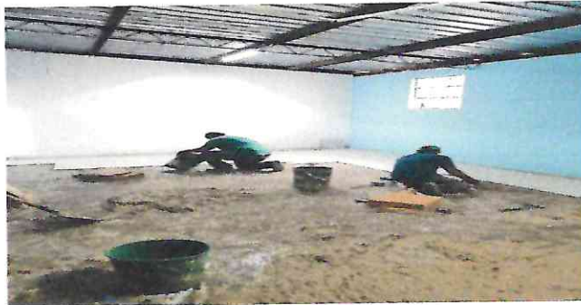
Foto 11: colocación de piso cerámico en el aula.
