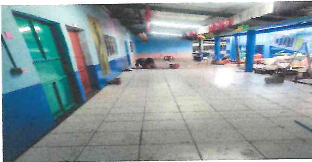
Foto 3: colocación de piso cerámico en el pasillo del modulo 1.
