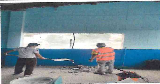
Foto 5: demolición y creación de espacio para la ventana en el aula.
