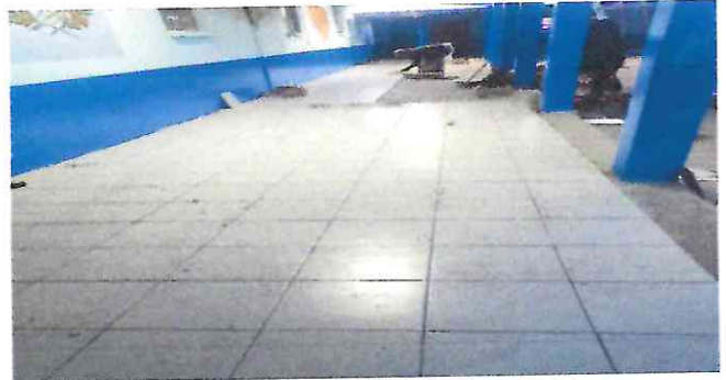
Foto 2: Colocación de piso cerámico en el pasillo.
