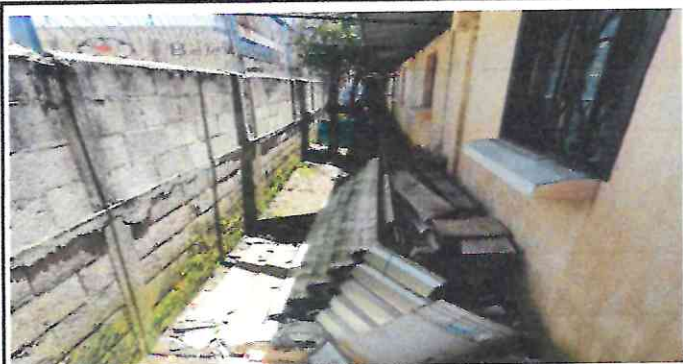
Foto 13: Limpieza, elaboración de losa de patio.
