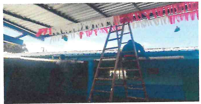
Foto 10: Desmontando el tubo obsoleto para agua pluvial.
