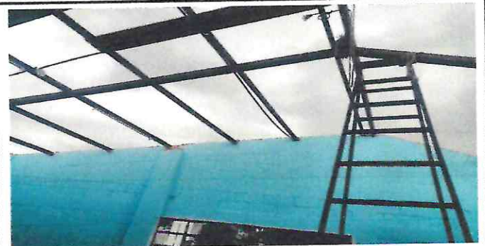
Foto 6: desmontaje del techo del aula para instalar o colocar lámina troquelada.
