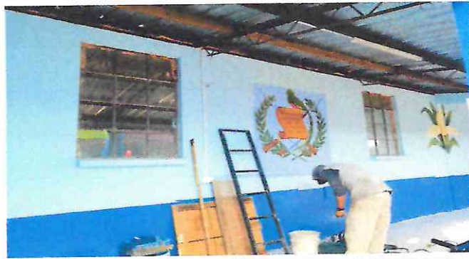
Foto 14: Instalación de 4 balcones.
