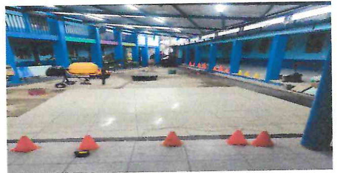
Foto 4: colocación de piso antideslizante en el patio cívico e instalación de lámparas en el techo.
