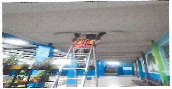
Foto 8: cambio de lámparas del primer y segundo nivel del módulo 3.
