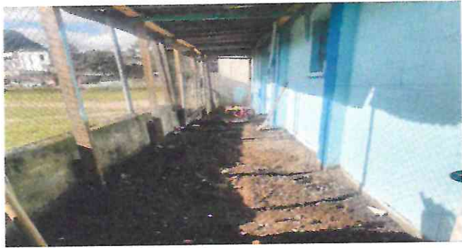
Foto 7: limpieza del área para la fundición de una losa de cemento.
