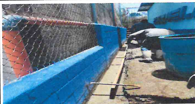
Foto 15: Elaboración de cuneta de concreto.
