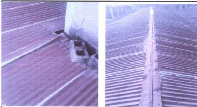
Foto1: Cambio de hojas de lámina del techo de la escuela y de capotes
