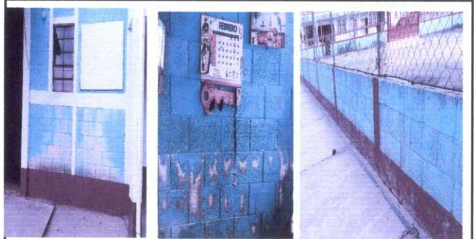
Foto 4: Repintada de edificio escolar exterior e interior así mismo la cancha plideportiva
