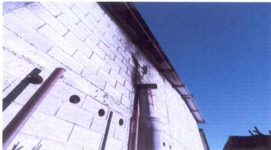
Foto 11: Reparación de área de cocina específicamente de cambio de tubo de chimenea
