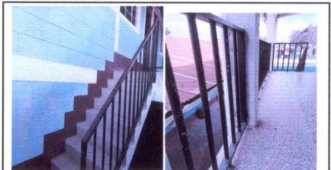
Foto 6: Repintada y mantenimiento de barandas
