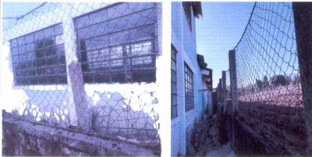
Foto 9: Cambio de maya en la parte exterior de edificio escolar
