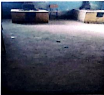
Foto 3: El piso de la cocina es de torta y ya está en mal estado.
