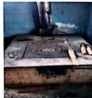
Foto 6: Las estufas de la cocina están en mal estado, y la plancha está oxidada.
