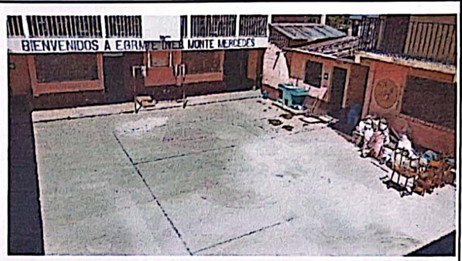
Foto 2: Sistema de captación de agua pluvial de techo a patio
