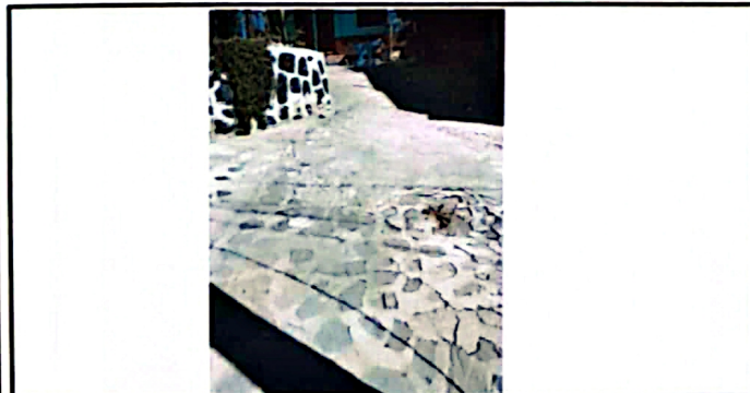
Foto 5: Área donde se colocará adoquín.
