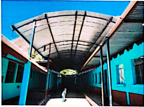
Foto 1: Área donde se colocará el techado y laminado.
