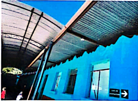
Foto 3: Área donde se colocará el techado e iluminación.
