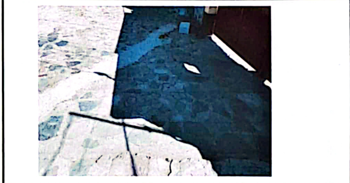
Foto 4: Entrada de la escuela donde se colocará adoquín.
