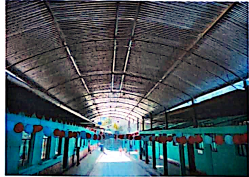
Foto 4: Área donde se colocará la iluminación.
