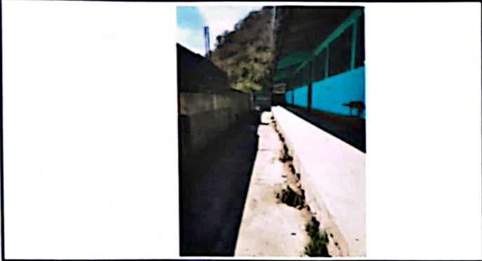
Foto 1: Área de corredor donde se colocará piso.
