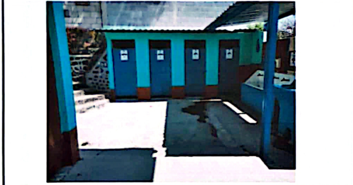
Foto 3: Área donde se colocará piso.
