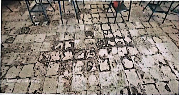
FOTO No. 1: Vista panorámica del piso de una de las cuatro aulas que se necesita sustituir dicho piso.
