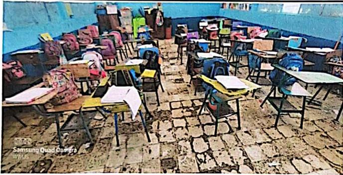
FOTO No. 3: Vista del piso en mal estado por la antigüedad
