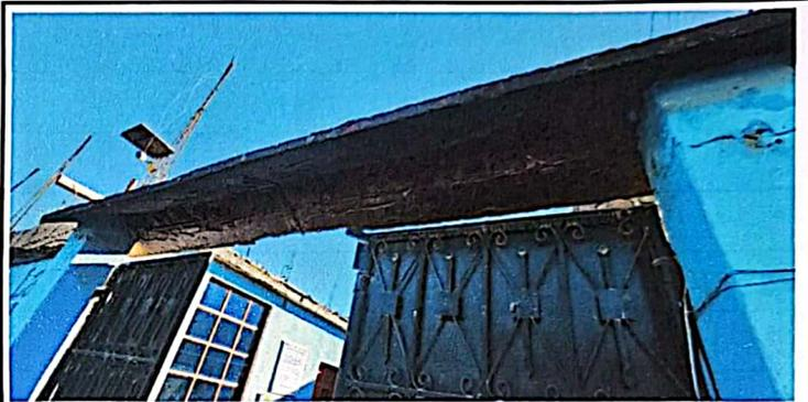
FOTO No. 4: Vista del portón de la entrada principal, que por la lluvia y sol ya se encuentra en mal estado.
