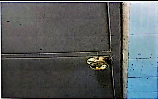
Foto 11: sustitución de chapa
