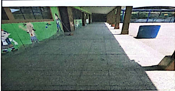
Foto 1: En esta fotografía se observa el estado del piso que está muy gastado, por lo tanto se requiere cambiar en todas las instalaciones de la escuela.
