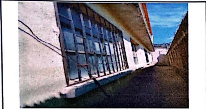
Foto 1: Balcones en mal estado, otras se desprendieron de las ventanas
