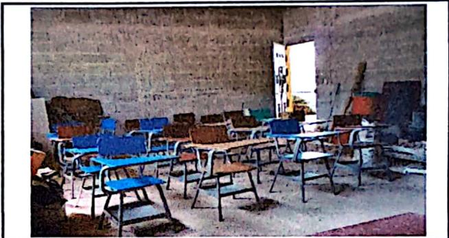
Foto 2: No existe piso solo un cernido de mal estado
