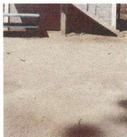
Foto 9: Torta de concreto de patio debido a tierra del exterior se ha dañado por lo cual requiere cambio.
