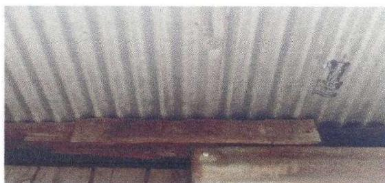
Foto 5: Cubierta de techo y estructura portante de techo requiere cambio.
