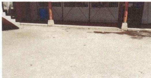
Foto 7: Torta de concreto de patio debido a tierra del exterior se ha dañado por lo cual requiere cambio.
