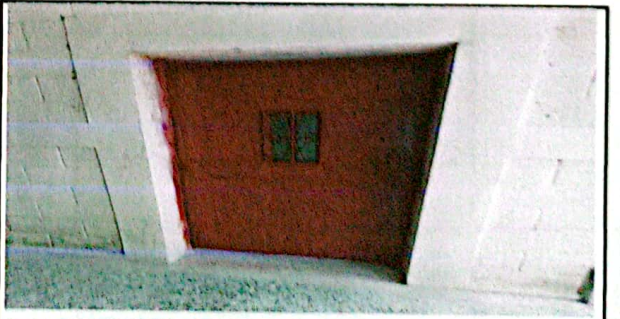
Foto 12: SUMINISTRO E INSTALACIÓN DE PUERTA DE METAL CON CHAPA
