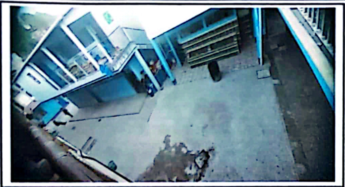
Foto 1: El patio cívico necesita mantenimiento
