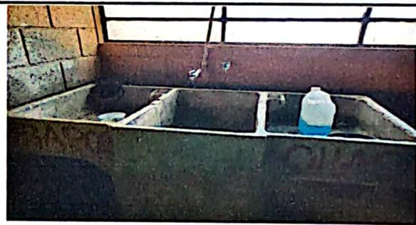
Sustitución de pila de cemento en mal estado, colocación de azulejo para evitar la humedad generado por agua y corrección de red de agua potable y drenaje.
