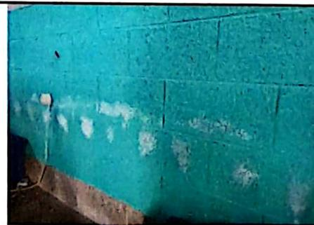
Cernido de pared por filtración de agua durante la temporada de lluvia y pintado de pared.
