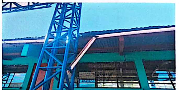
CAMBIO DE CANALES Y BAJADA DE PLUVIAL
