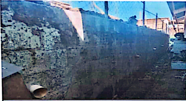
REPARACION DE MURO DE CONTENCIÓN
