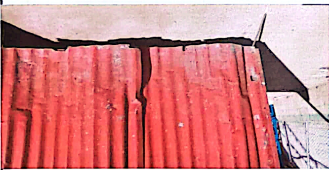
MANTENIMIENTO DE PORTÓN
