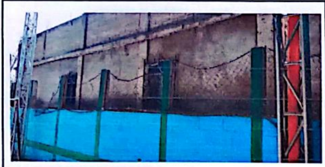
Foto 1: seguimiento de pared y colocacion de malla perimetral
