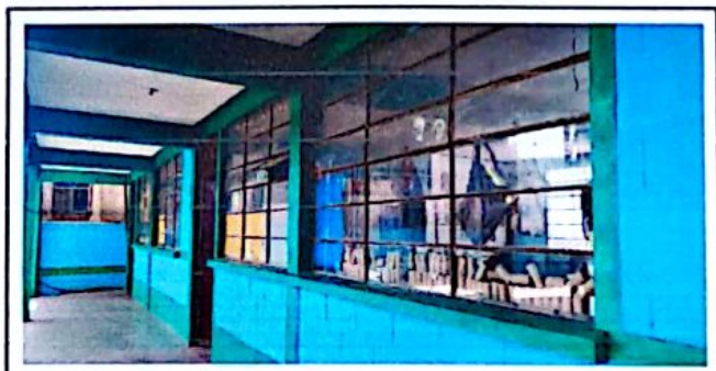
Foto 4: Colocacion de barandas
