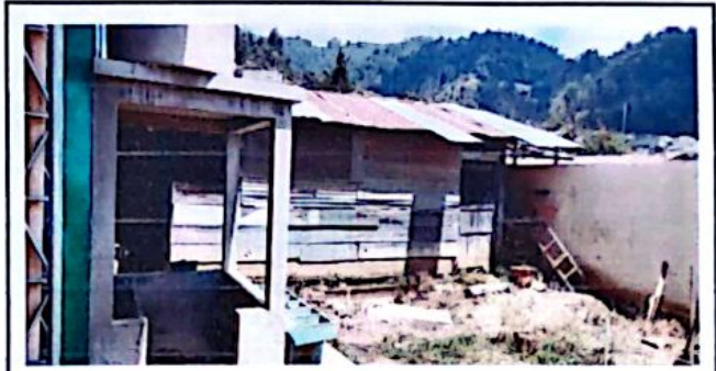
Foto 2: Sustitucion de tablas por block y cambio de laminas
