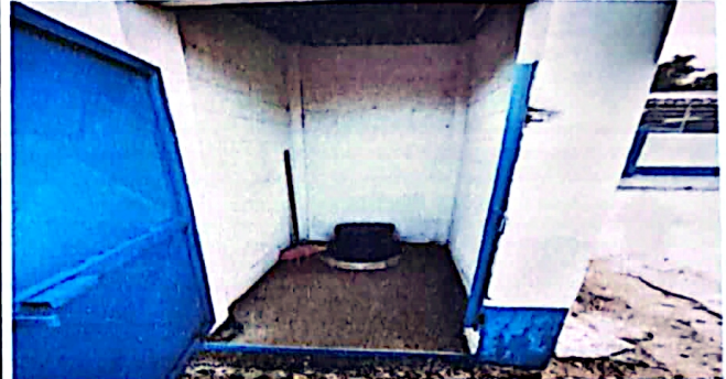
Foto 2: Cambio de letrinas a sanitarios.
