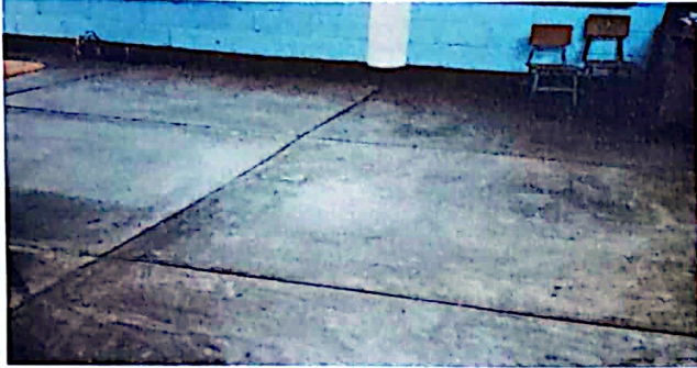
Foto 1: Cambio de piso en las aulas y la cocina.
