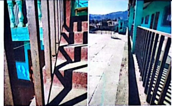
Foto 2: Cambio y pintadas de barandas del corredor del segundo nivel de la escuela.
