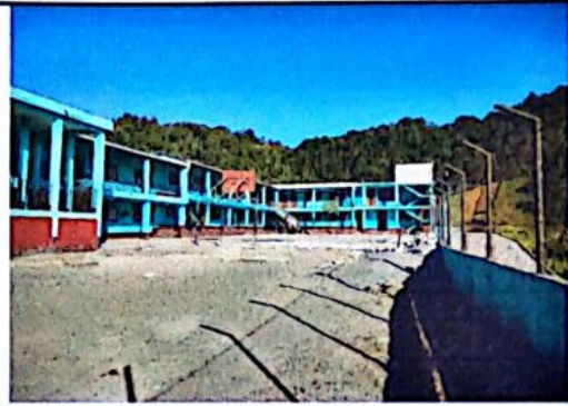
Foto 4: Pintada exterior e interior de la escuela.
