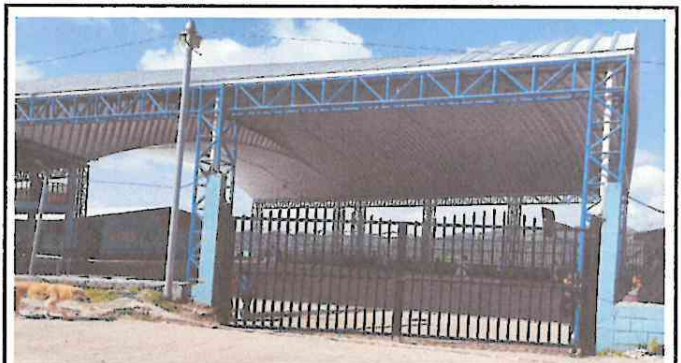
Foto 4: Colocación del portón de barandas.
