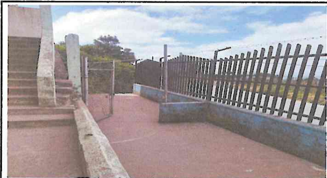
Foto 3: Colocación de barandas.
