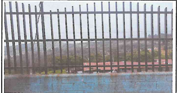
Foto 2: Colocación de barandas.
