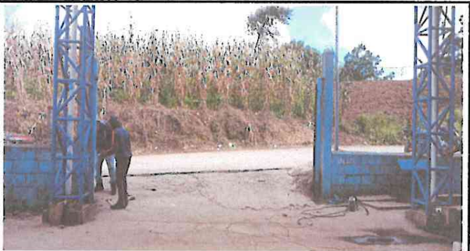
Foto 4: Eliminacion del portón de malla.
