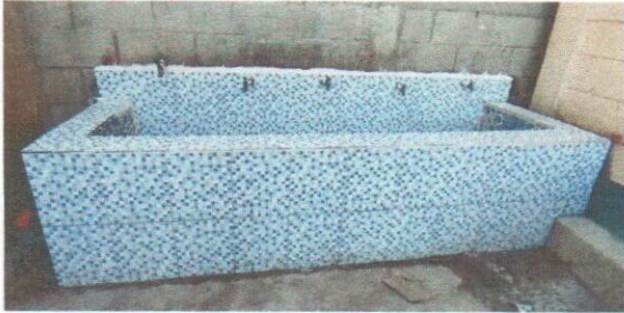
Foto 7: Mejoramiento de lavamanos con azulejo de cocina.
