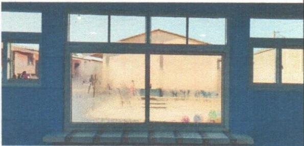
Foto 11: Instalación de ventanas de UPVC en cocina.
