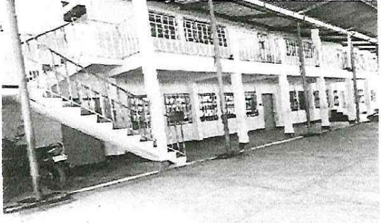
Foto 5: Pintura en muros interior y exterior
