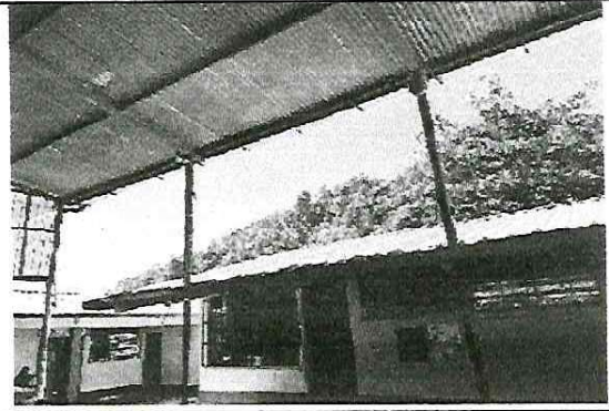
Foto 2: Colocación de barandas
