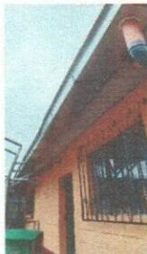
Foto 5: Instalación de canal de aluzinc en modulo de aulas II.
