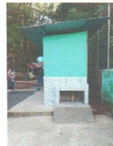
Foto 6: Mejoramiento de servicios sanitarios.
