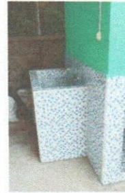
Foto 2: Mejoramiento de lavamanos.
