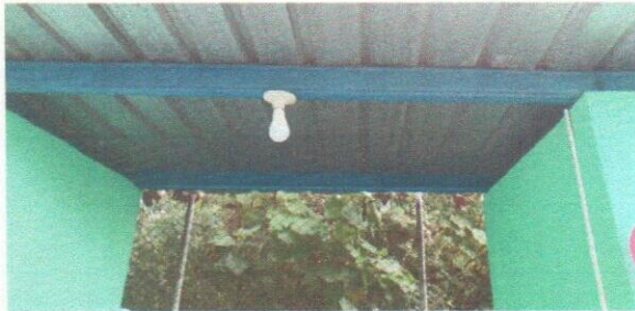
Foto 3: Mejoramiento de sistema eléctrico.
