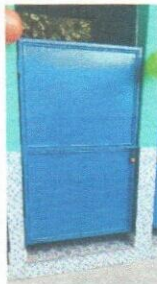
Foto 5: Mantenimiento de puertas de metal.
