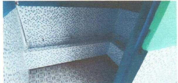
Foto 4: Mejoramiento de mingitorio.
