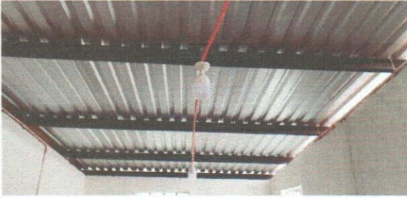
Foto 1: Mejoramiento de techado de aulas, sistema eléctrico y pintura en muros internos, en modulo de aulas 1.
