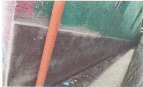
Foto 4: Repello en pared, en modulo de aulas 1.
