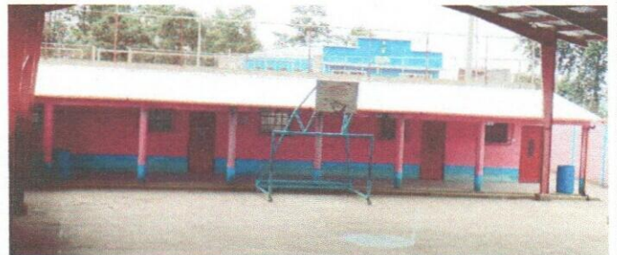
Foto 6: Vista general de modulo de aulas 1.
