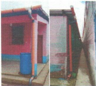
Foto 5: Mejoramiento de canales y bajadas de agua pluvial, en modulo de aulas 1.
