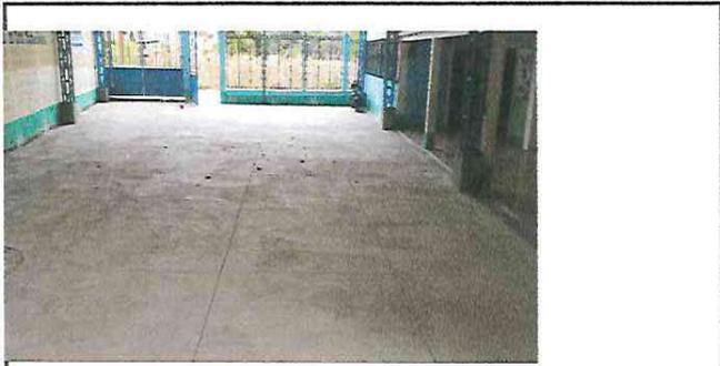
Foto 1: Terminación de losa de patio con concreto simple
