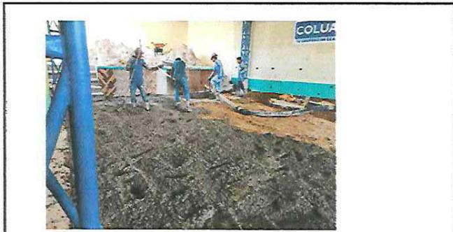
Foto1: Fundición de losa de patio con concreto simple
