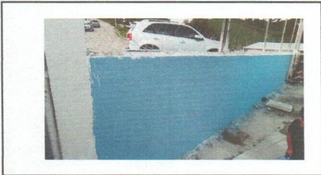
Foto 9: Mejoramiento de muro perimetral con repello y pintura.
