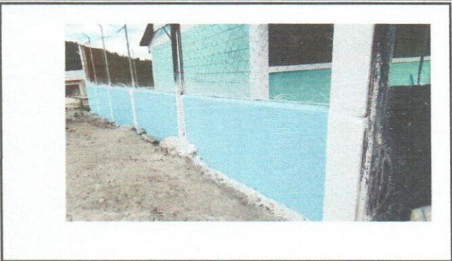
Foto 7: Mejoramiento de muro perimetral con repello y pintura.
