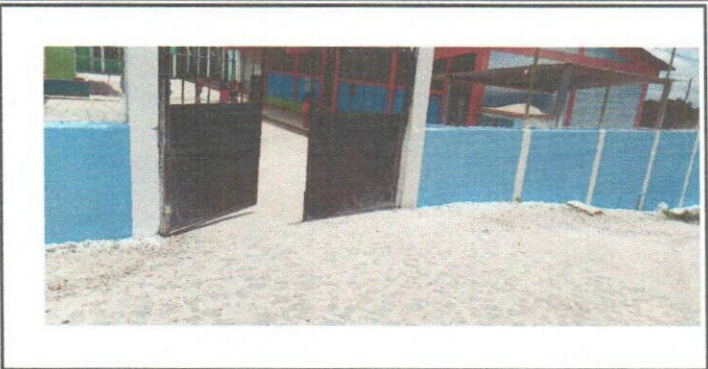
Foto 8: Mejoramiento de muro perimetral con repello y pintura.
