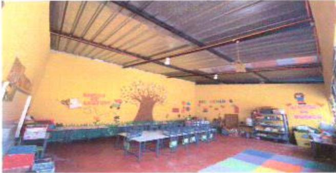
Foto1: En los tres techos hay muchos goteras en tiempo lluvioso
