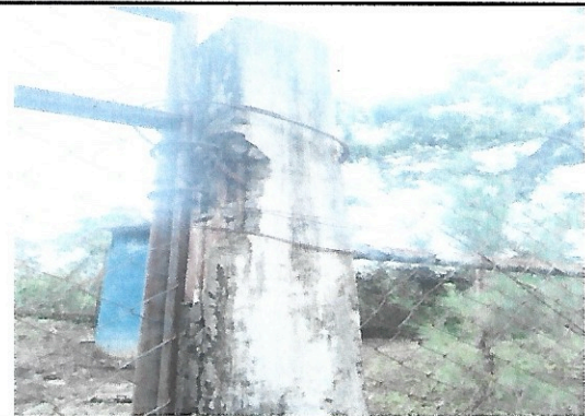
Foto 4: Mejoramiento de las bases del porton principal.
