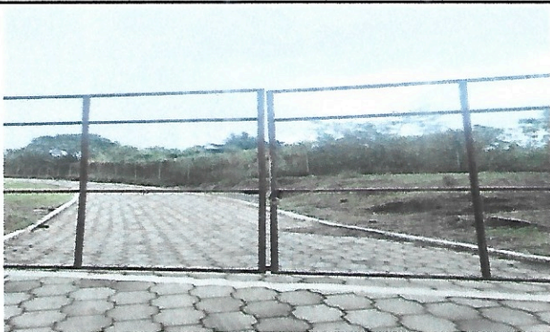
Foto 3: Mejoramiento de Porton Principal.
