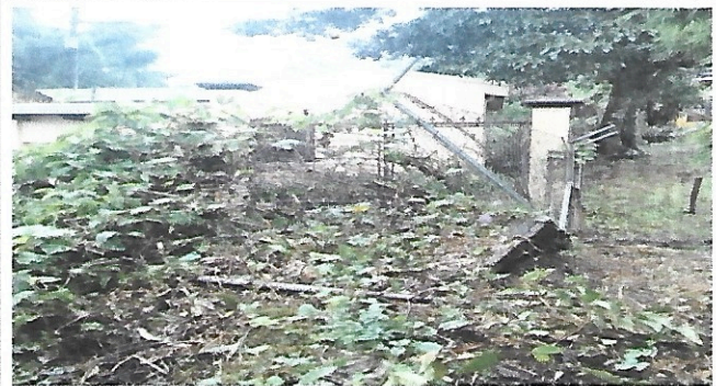
Foto 6: Mejoramiento de cerco o muro perimetral.
