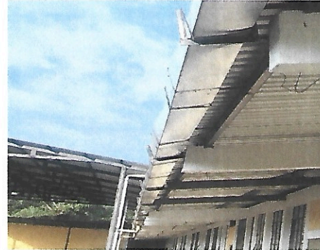
Foto 2: Mejoramiento de sistema de canales.
