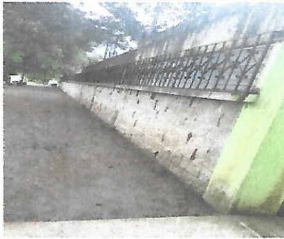
Foto1: fundición de pestaña para evitar caída de agua en paredes
