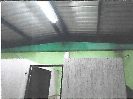
Foto 5: Reparación de techo en sanitarios del segundo nivel
