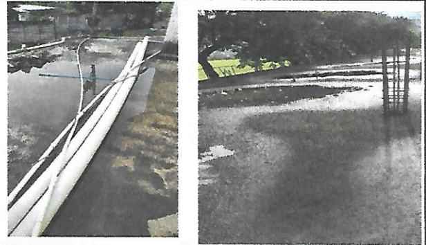
Foto 2: Elaboración de pañuelos para impermeabilización y conducción de agua a tubería.
