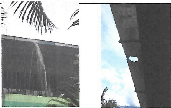
Foto 3: Cambio de canales
