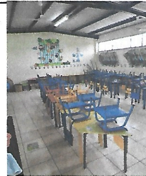
Foto 4: Colocación de cielo falso a 3 salones del segundo nivel
