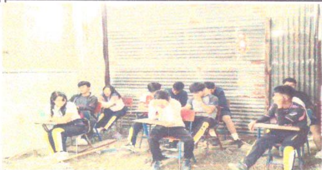
foto 3: se muestra la pared en lado norte del aula asignada a cuarto Bachillerato en Ciencias y Letras con Orientación en Computación
