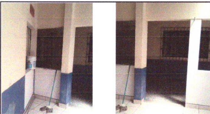
Foto 3: Puerta y ventana en el ingreso a cocina.
