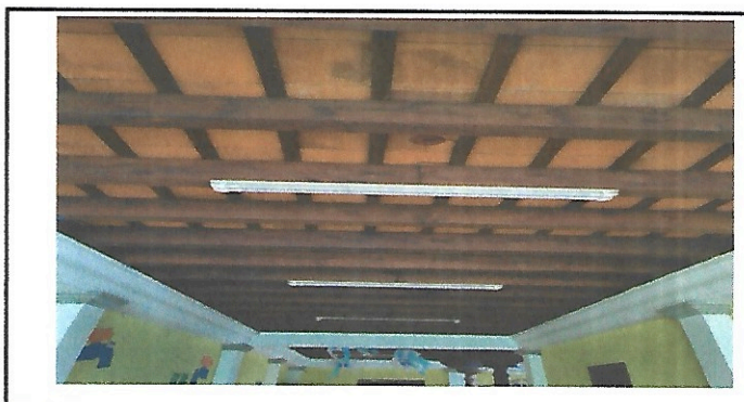
Foto 6: Estado actual de vigas, pasillo de preprimaria
