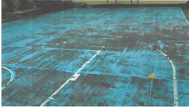
Foto 1: Estado actual de pintura de cancha
