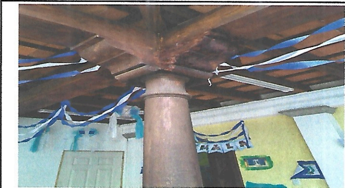
Foto 3: Estado actual de vigas y columnas patio de cocina
