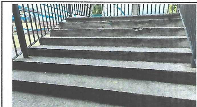
Foto 4: Estado actual gradas para subir a planta alta dos lado este
