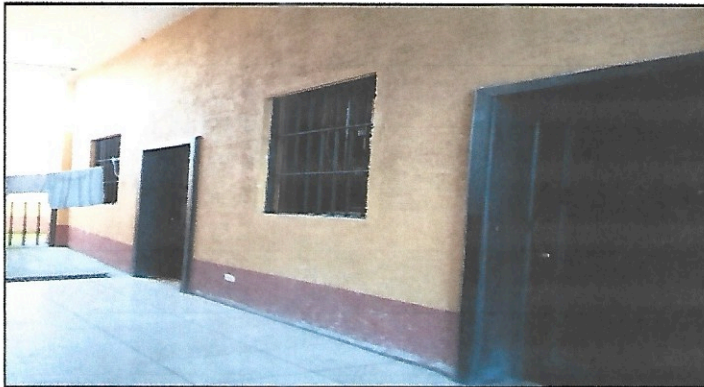
Foto 3: PINTURA Y ENERGÍA ELECTRICA COCINA Y BODEGA
