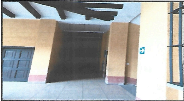
Foto1: PINTURA Y ENERGÍA ELECTRICA PRIMER NIVEL ÁREA PASILLO
