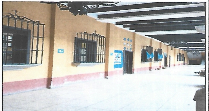
Foto 4: PINTURA Y ENERGIA ELECTRICA AULAS Y CORREDORES
