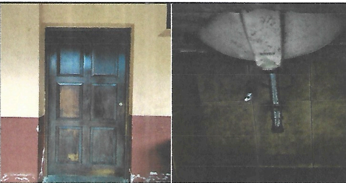
Foto 5: reparación de puertas y lavamanos de los baños de la planta baja
