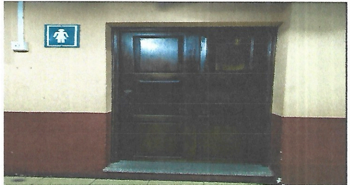
Foto 2: reparación de puertas en los sanitarios para señoritas, en el primer y segundo nivel.
