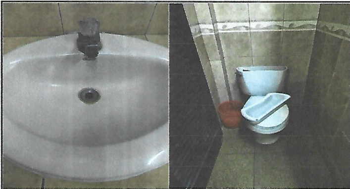
Foto1: cambio de lavamanos y sanitarios en el primer y segundo nivel.
