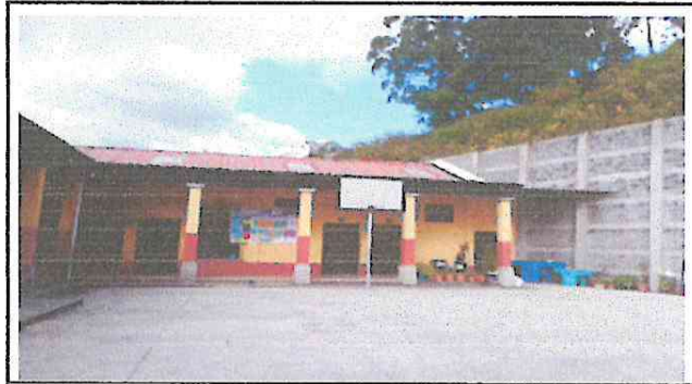
Foto 2: se creo el espacio para una bodega
