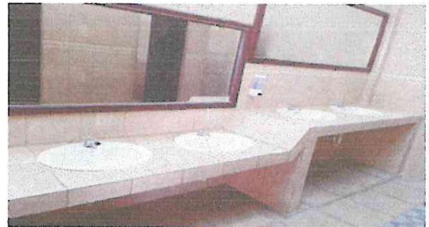
Foto 4: lavamanos y chorros reparados
