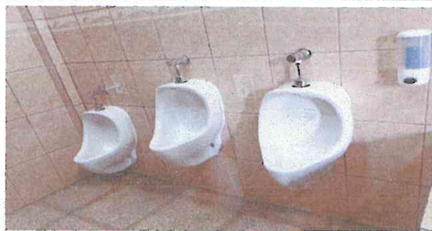
Foto 5: mijitorios cambiados y arreglados
