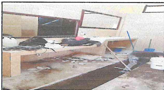
Foto 4: lavamanos y chorros en proceso de repación
