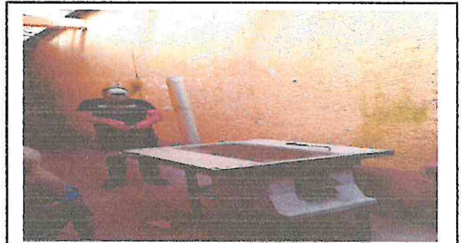
Foto 4: ambiente para crear una cocina esta siendo remodelado
