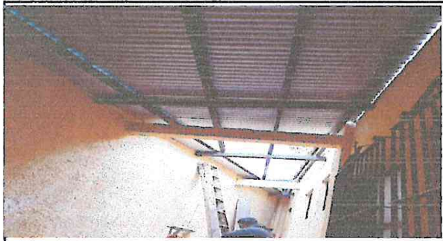
Foto 1: arreglando el techo en mal estado
