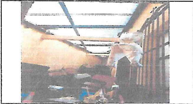
Foto 3: espacios mal acondicionados
