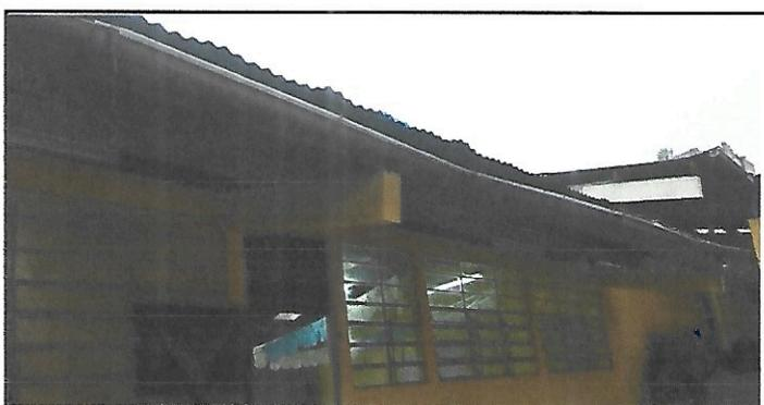
Foto 5: Estado actual de canales del techado en mal estado.
