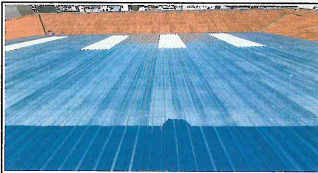
Foto1: Foto tomada desde arriba (lado central).
