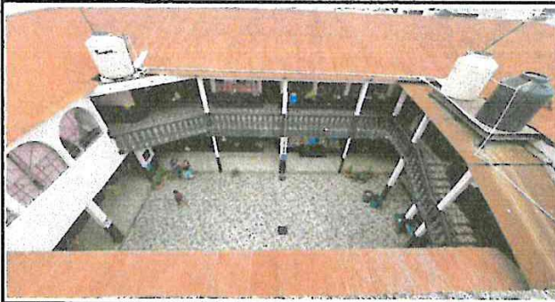
Foto1: Foto tomada desde arriba (lado central).
