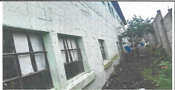
Foto 4: foto del estado actual de ventanas sin balcón
