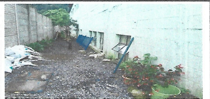
Foto 6: estado actual sin balcón
