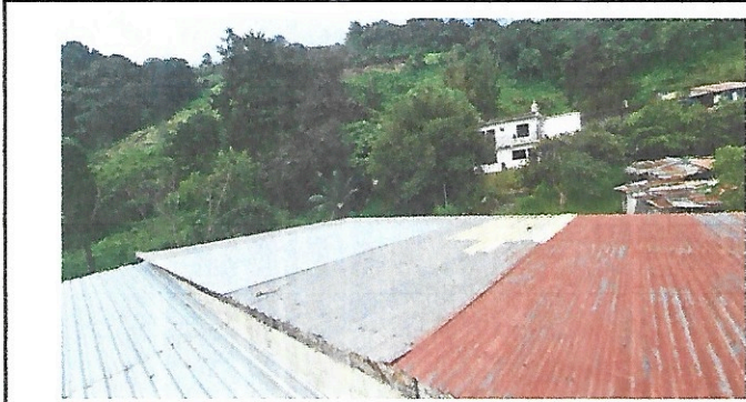
Foto1: Estado actual del techado
