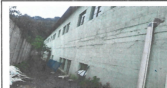
Foto 5: Parte exterior de ventanas sin balcón
