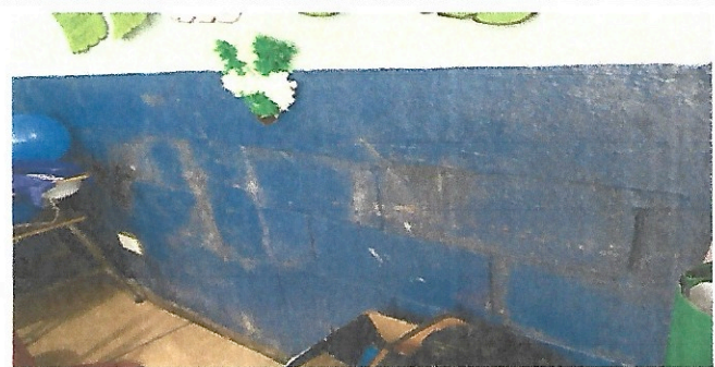
Foto 6: pintura dañada por humedad en salón de clases.
