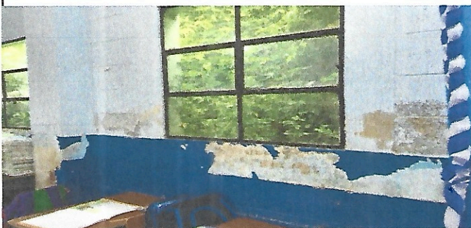
Foto 5: Interior de otro salón con pintura dañada por demasiada humedad.
