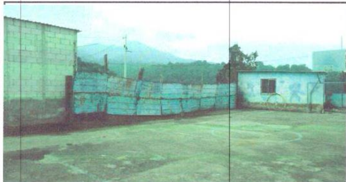
FOTO 1: MURO PERIMETRAL, PARTE DE ENFRETE
