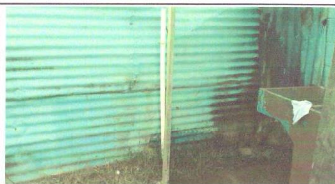
FOTO 4: MURO PERIMETRAL PARTE ESTE PEGADO A LOS BAÑOS
