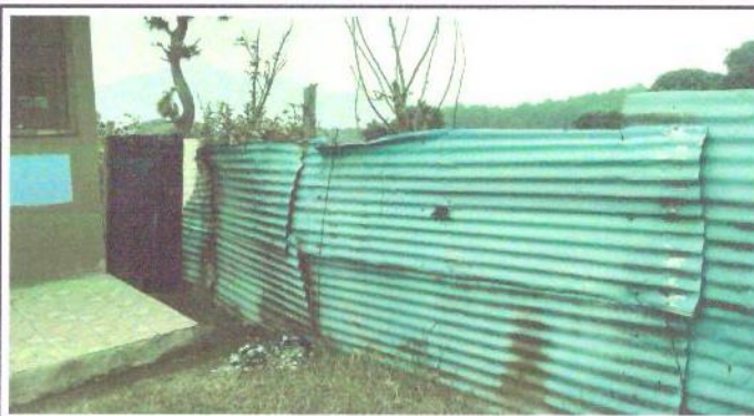
FOTO 2: MURO PERIMETRAL PARTE ESTE
