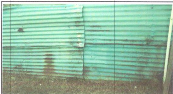
FOTO 3: MURO PERIMETRAL PARTE ESTE
