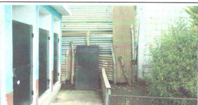
FOTO 6: MURO PERIMETRAL, ESQUINA DE LOS BAÑOS
