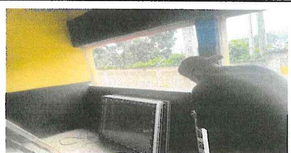
Foto 2: Colocacion de ventana a PVC
