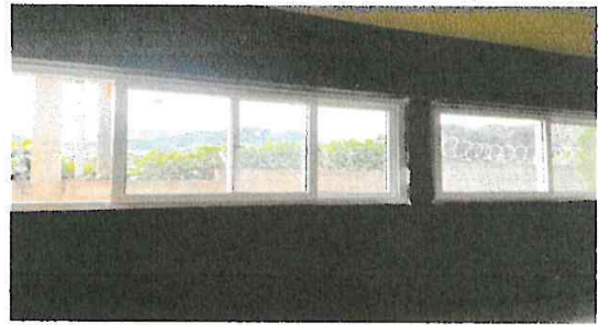
Foto 2: Colocación de ventana a PVC
