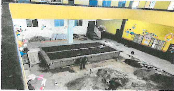
Foto1: Construcción de escenario
