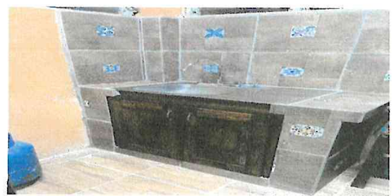
Foto 4: Instalación de lavatrastos y filtro para agua
