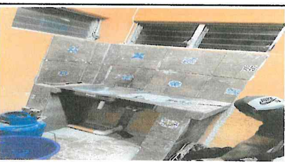
Foto 4: Instalacion de lavatrastos y filtro para agua
